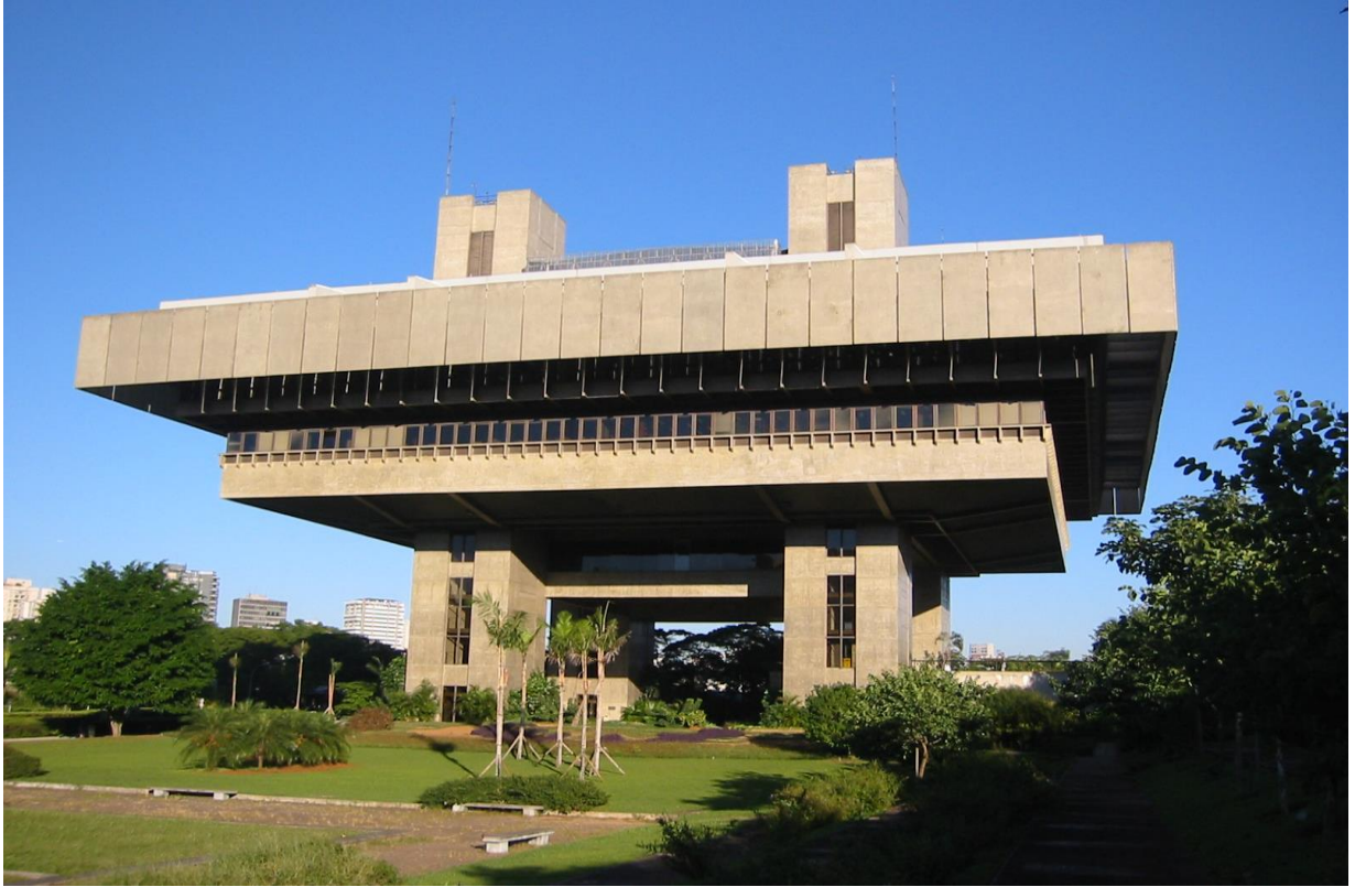
Foto 1: Visão geral do prédio
